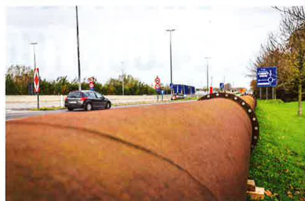
Om (bepaalde stukken van) de collector te kunnen herstellen zonder dat de afvoer van het afvalwater naar de waterzuiveringsinstallatie moest worden stopgezet, is er een bovengrondse noodleiding geplaatst.
