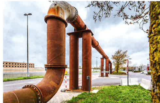
Het anderhalf kilometer lange traject werd opgedeeld in vijftien deelsegmenten, waarin telkens een kous werd aangebracht.
