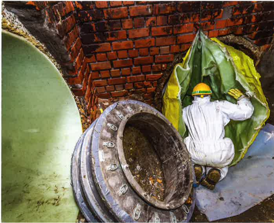
Het anderhalf kilometer lange traject werd opgedeeld in vijftien deelsegmenten, waarin telkens een kous werd aangebracht.
