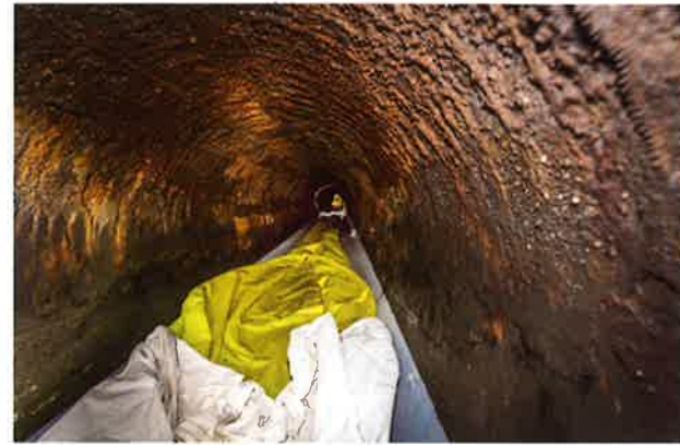
Het anderhalf kilometer lange traject werd opgedeeld in vijftien deelsegmenten, waarin telkens een kous werd aangebracht.
